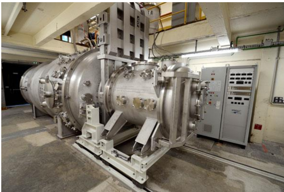
Figure 1 : Image du caisson ERIS en cours d'installation
